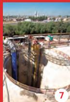
**6. TORRE REFORMA** - México, CDMX. Cimentación con base en muro Milán estructural desplantado a 60 m, así como subestructura para la torre más alta de México.
